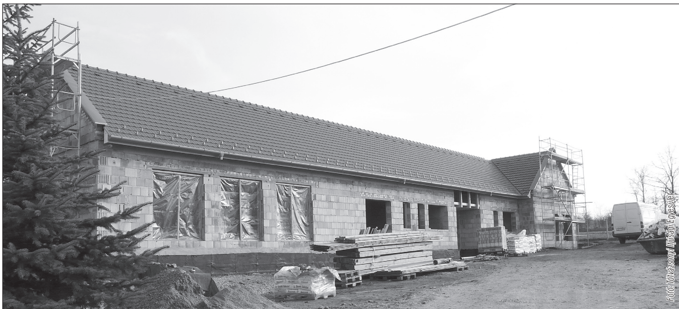
Jó ütemben halad az új óvoda építése
