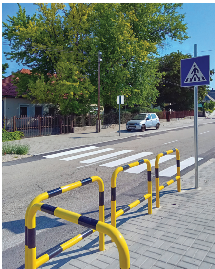
Hajnal utca parkoló építése, gyalogátkelőhely kialakítása
