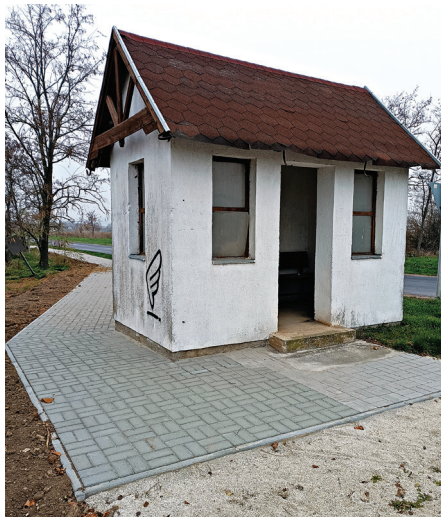
Kövesgyűrpuszta bekötőútra épített járda
